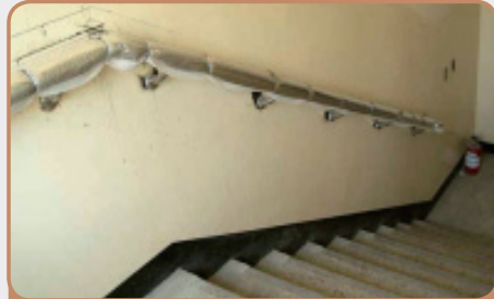
보온재를 이용한 난간 보양 사례
